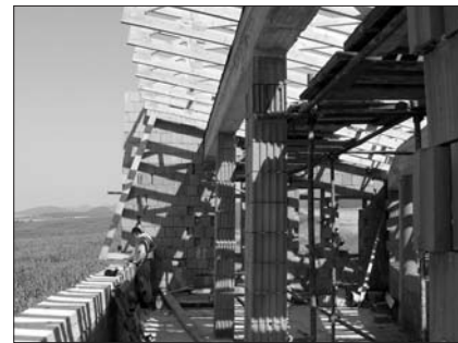
2. Obergeschoss Hier entstehen die zukünftigen Büroräume
