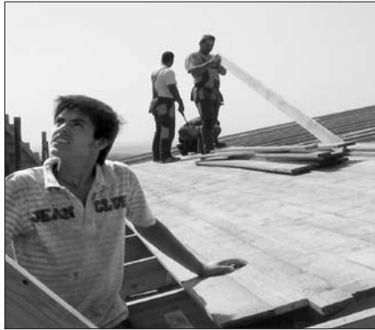
Das Dach wird gedeckt
