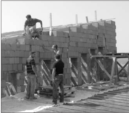
Vorbereitungsarbeiten für den Dachstuhl
