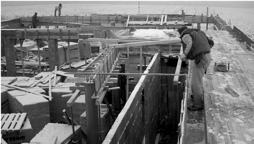
Das zweite Stockwerk wird vorbereitet
