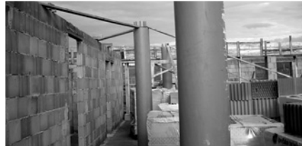
Die Mauern werden erstellt
