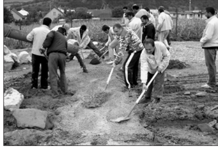
Beim Betonieren des Fundaments
